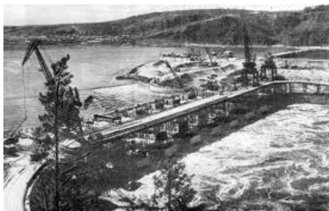
Строительство Братской ГЭС, 1954 г.
