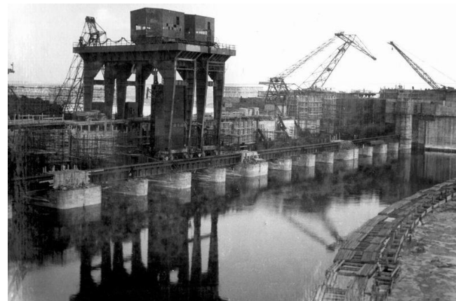
Строительство Иркутской ГЭС
