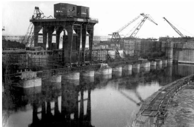
Строительство Иркутской ГЭС, 1950 г.
